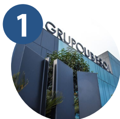
Grupo Ubesol Atzeneta d'Albaida - Valencia Oficinas centrales.
